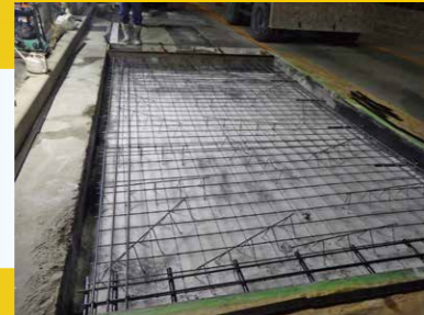
型枠・鉄筋設置
